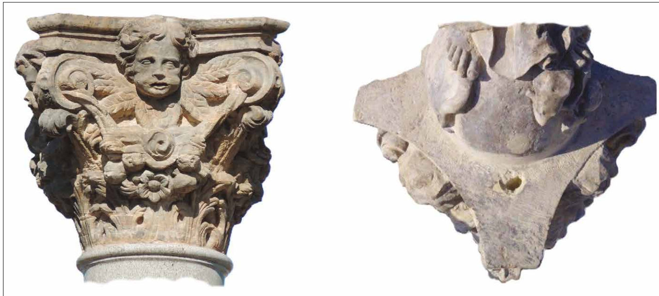
Obr. Pohled na jižní stranu hlavice sloupu a vpravo pohled shora na její horní desku (abaku) s vyvrtanou dírou k upevnění poloviny měsíčního srpku.
