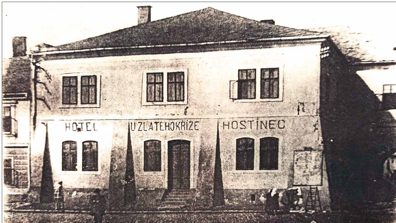
Obr. Pohled na „HOTEL U ZLATÉHO KŘÍŽE HOSTINEC“ zřejmě z roku 1908, kdy došlo k elektrifikaci města Kojetína, protože na rozích budovy jsou již zabudovány konzoly s porcelánovými izolátory drátů.
