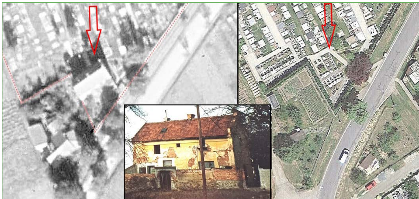
Obr. Letecký snímek domu hrobníka z roku 1946, vpravo současný stav, pohled na dům před jeho zbouráním v roce 1991.
