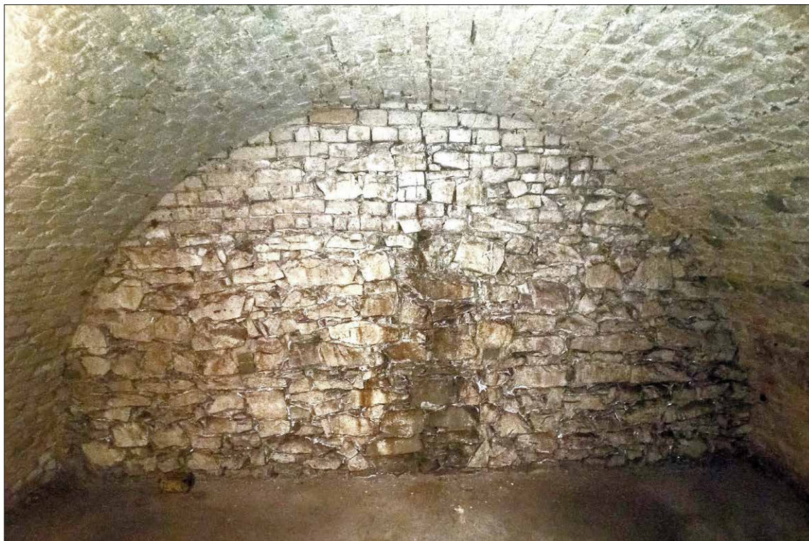
Obr. Pohled na sklepní zed', uzavírající sklepení ze severní strany (směrem do dvora).
