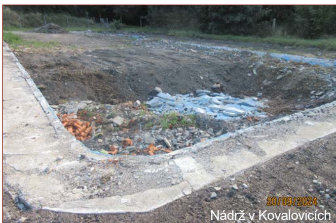
05/10/2024 Nádrž v Kovalovicích
