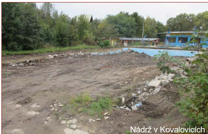
29/06/2024 Nádrž v Kovalovicích
