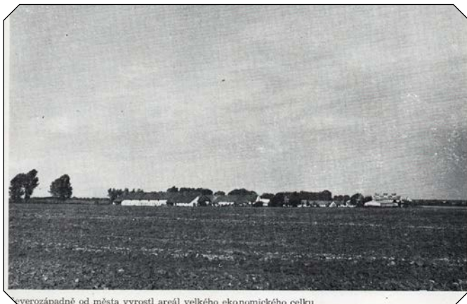
Severozápadně od města vyrostl areál velkého ekonomického celku
