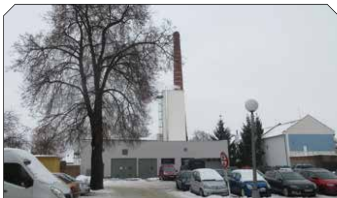
2022 - rekonstrukce kotelny K 3 - ul. Nová - 15,1 mil. Kč bez dotace
