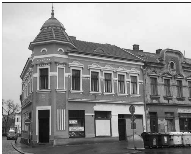
Na rohu Tyršovy ulice a náměstí Míru je velmi pěkně opraven dům č.p. 29. Chvályhodné je také to, že zůstaly zachovány nápisy na čelní straně.
