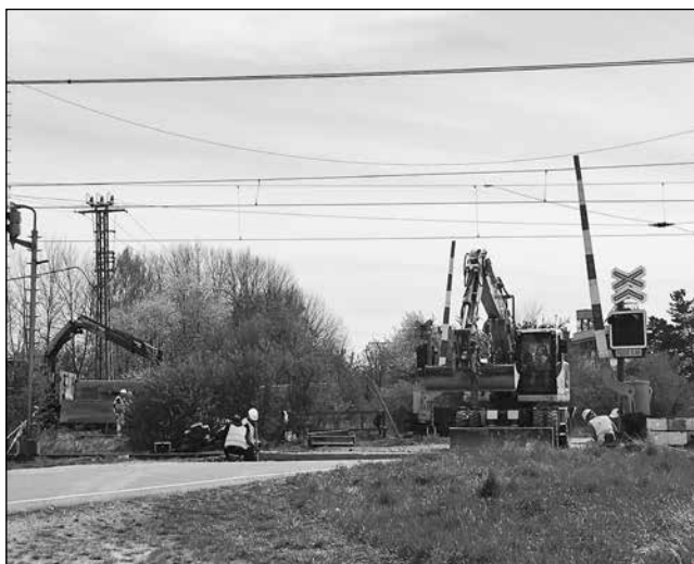
Opravy železničních přejezdů proběhly rychle a kvalitně během pár dubnových dnů - zde přejezd směrem na Popůvky na Křenovské ulici.
