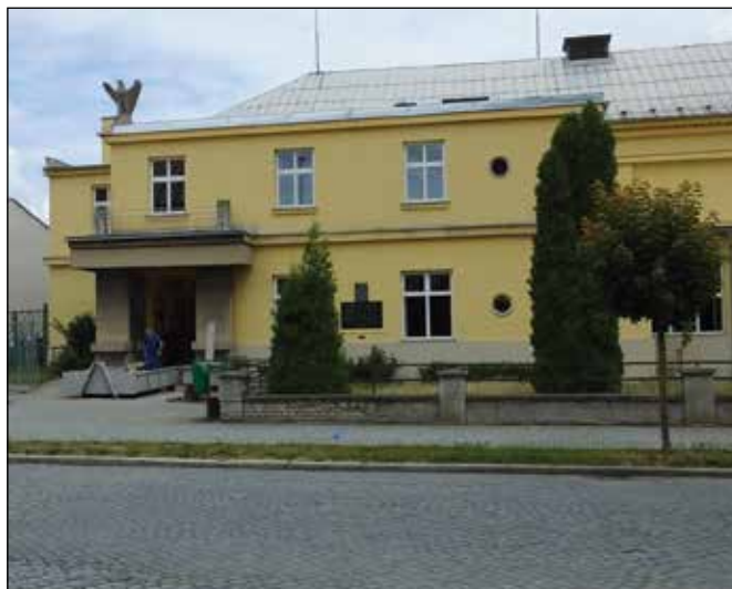
Budova sokolovny, jejíž interiéry procházejí totální obnovou. Celou akci financuje ze svého rozpočtu Město Kojetín a dokončena bude v průběhu příštího roku.
