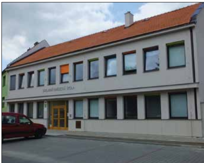
Nově zrekonstruovaná budova Základní umělecké školy v ulici Hanusíkova. Na její obnovu přispěl Olomoucký kraj částkou 6 milionů korun.
