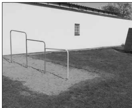
Částečná rekonstrukce hřiště – MŠ Masarykovo náměstí
