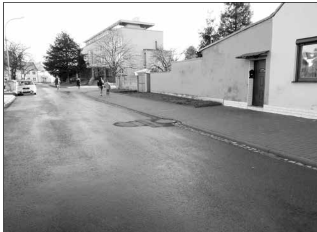
Oprava chodníku u polikliniky
