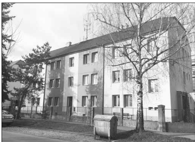
Oprava domu v Nádražní ulici
