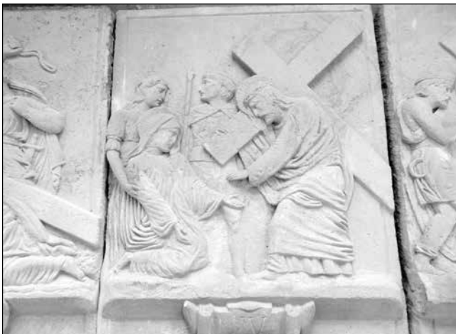
Renovace čtrnácti reliéfů křížové cesty
