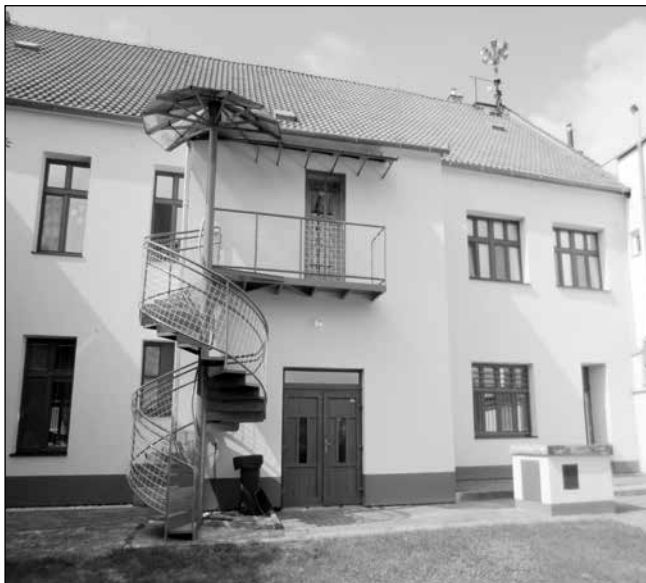
Zateplení dvorního traktu budovy MŠ Masarykovo náměstí
