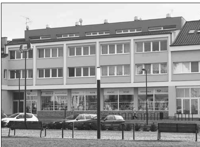
Oprava domu na Masarykově náměstí
