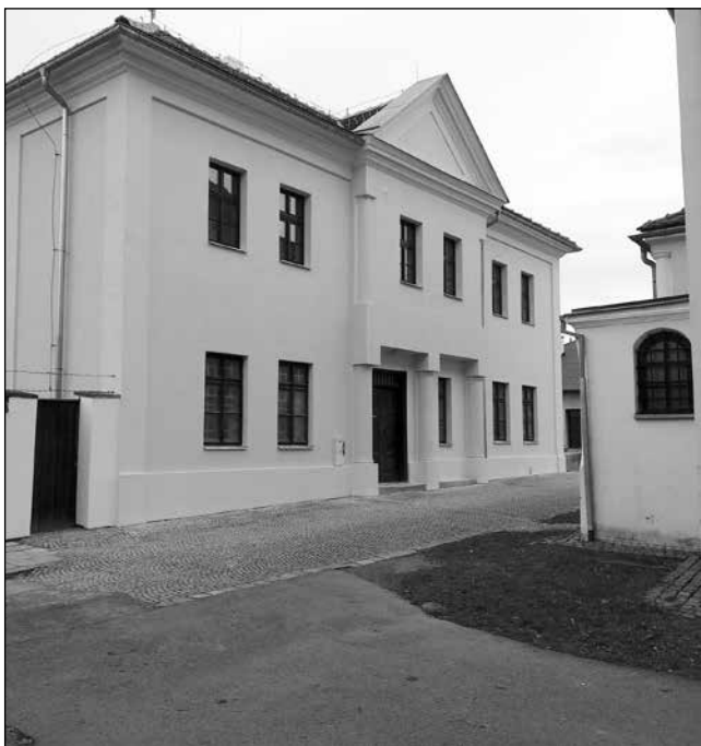
Opravený Rabínský dům
