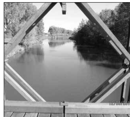
Pohled z mostního provizoria na most Dr. Šíleného
