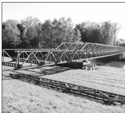
Cvičný most přes Moravu
