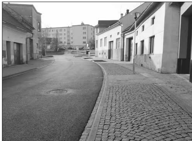
Oprava Mlýnské ulice
