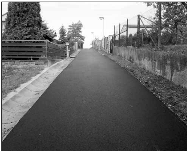
Oprava komunikace v Kovalovicích
