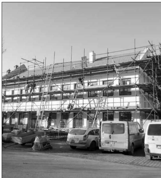
Oprava Základní umělecké školy Kojetín
