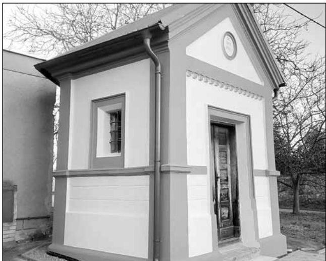
Oprava kaple sv. Jana Nepomuckého v Olomoucké ulici
