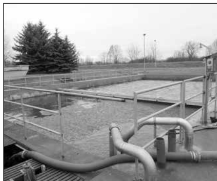
Objekt původní usazovací nádrže přeměněný na denitrifikaci a nitrifikaci
