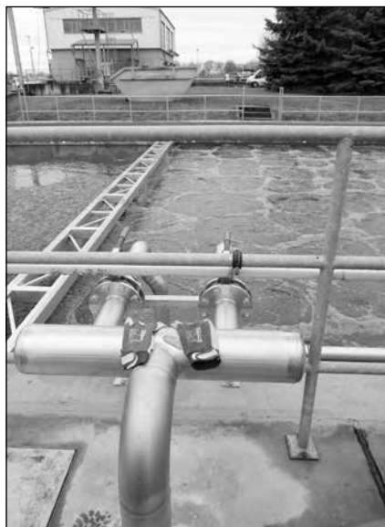
Původní usazovací nádrž přeměněná na objekt denitrifikace a nitrifikace
