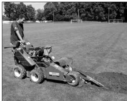
Hloubení výkopů na potrubí
