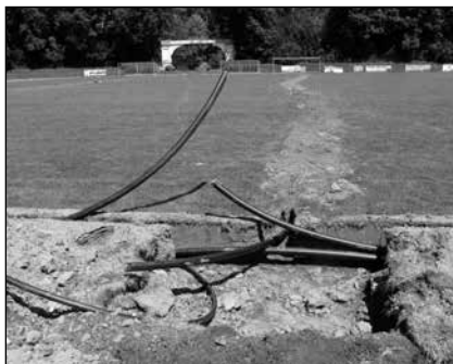
Příprava na spojení potrubí
