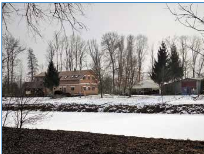
Loděnice - podoba vznikající budovy nové loděnice u řeky Moravy
