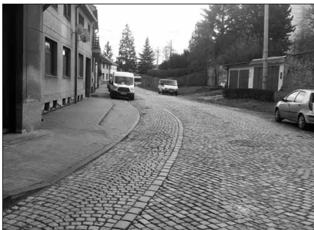
Oprava chodníků v ulici Podvalí
