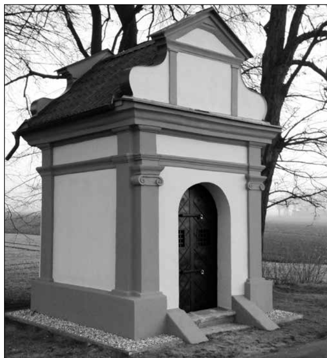
Renovace kaple sv. Anny u silnice do Měrovic
