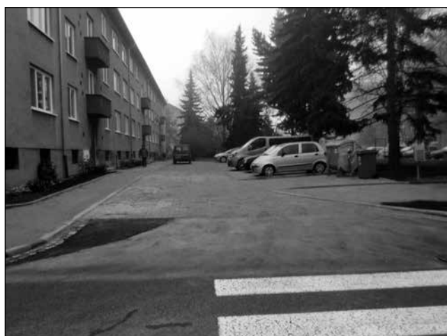
Úpravy na sídlišti Jih
