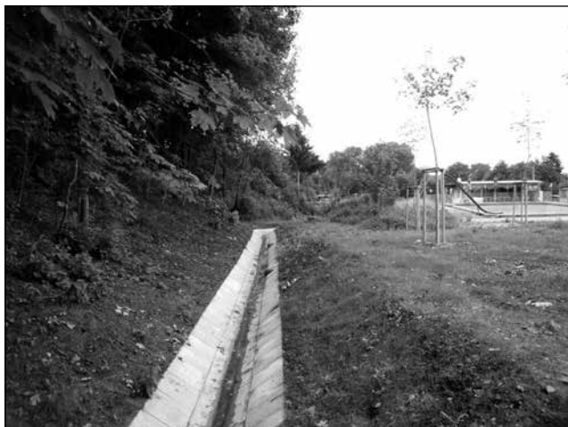
Odvodnění v Kovalovicích
