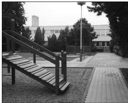
Opravené chodníky a nátěry na hřišti
