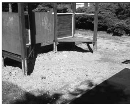
Hřiště před rekonstrukcí
