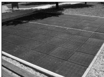
Mlhoviště po rekonstrukci
