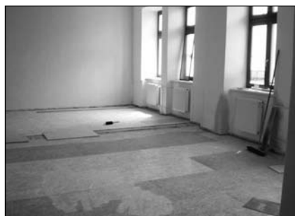
Podlaha před rekonstrukcí
