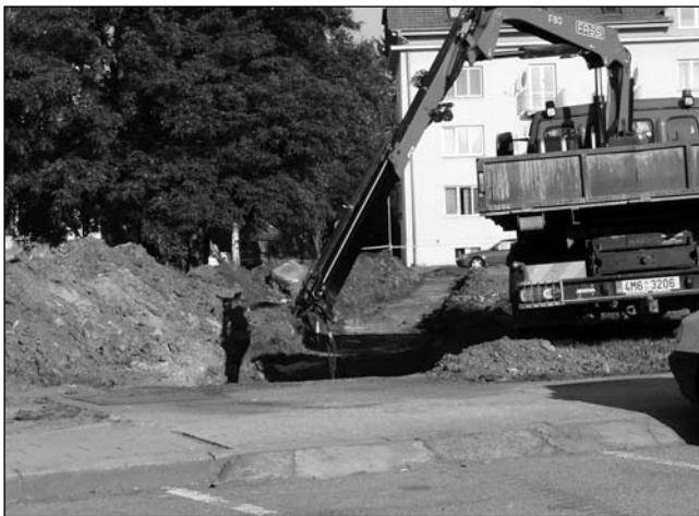
Výměna rozvodů tepla a teplé užitkové vody na sídlišti Sever
