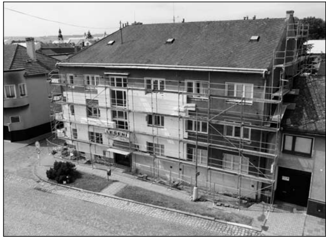
Probíhá zateplení budovy a výměna oken na DPS Dr. E. Beneše
