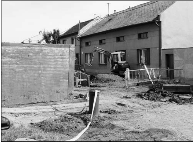
Další etapa budování kanalizace na ulici Padlých hrdinů je u konce
