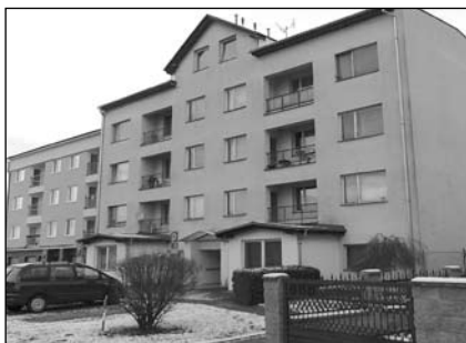
DPS St. Masara - oprava výtahu
