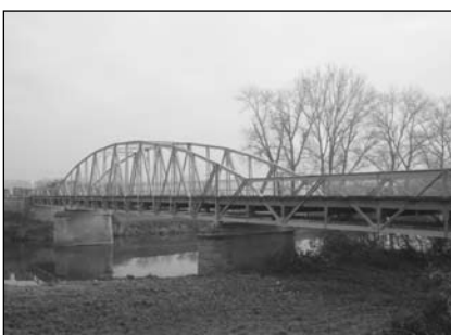
Oprava mostu Dr. Šíleného
