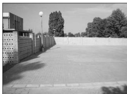
Oprava parkoviště u hřbitova
