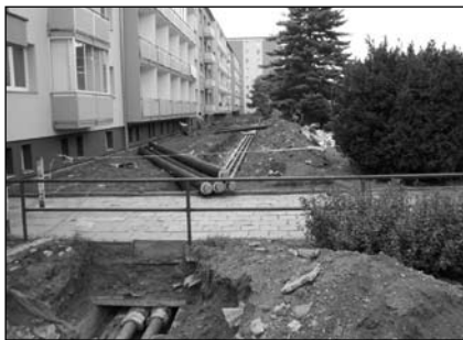
Oprava teplovodního kanálu na sídlišti JIH II. etapa
