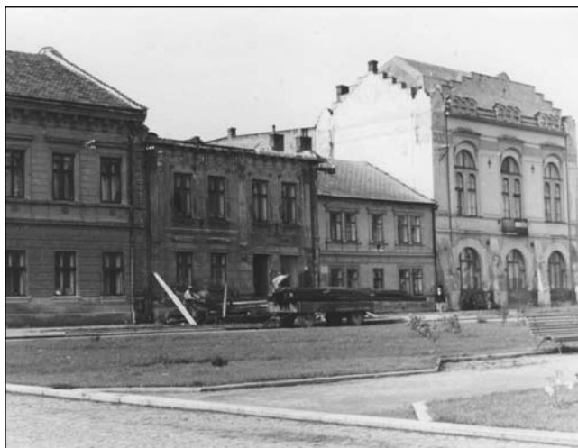
Demolice domu č. 10 - bývalé lékárny, na náměstí počátkem 70. let 20. století
