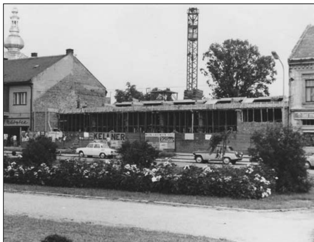
Stavba prodejny potravin na dnešním Masarykově (tehdy Gottwaldově) náměstí v roce 1974
