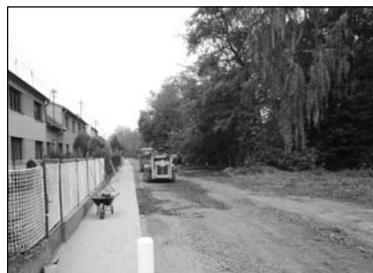
Oprava komunikace a chodníků ve Stružní ulici
