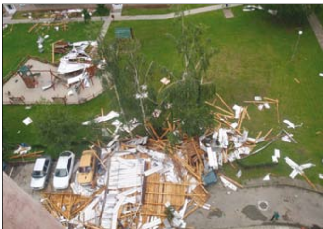
Sídliště Sever po vichřici
