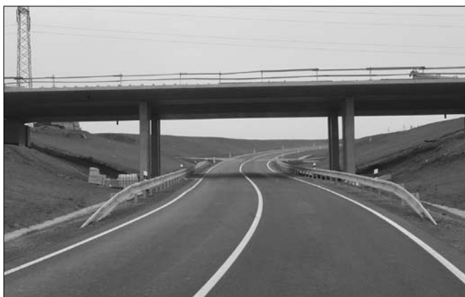
Dálnice D1 se opět přiblížila ke Kojetínu, na snímku nadjezd D1 u Kovalovic
