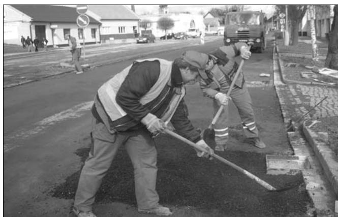
Opravy komunikací po opravě kanalizace - ulice Kroměřížská
