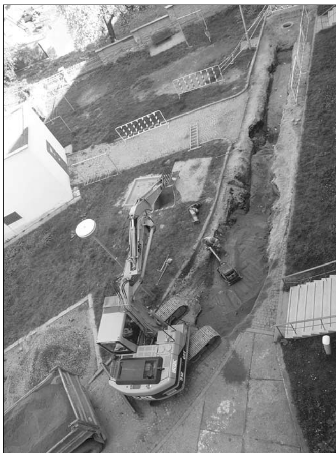
Budování kanalizace na Tržním náměstí
