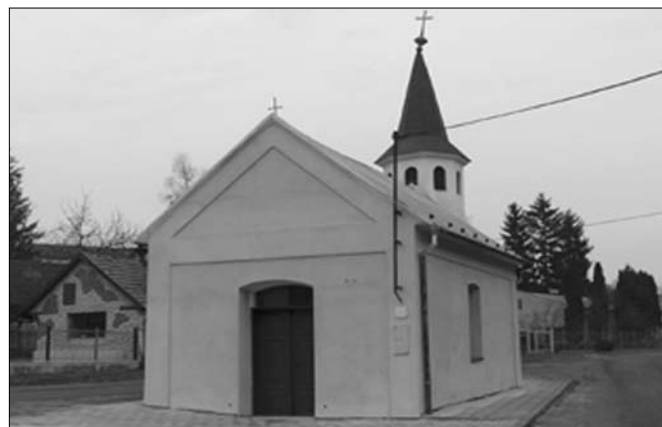
Oprava kaple sv. Františka v Kovalovicích
