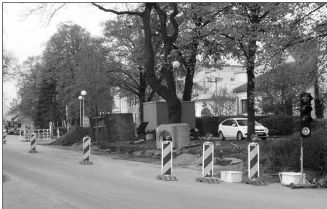
Opravy kanalizace v našem městě skončily, následovaly opravy komunikací - ulice Svatopluka Čecha
