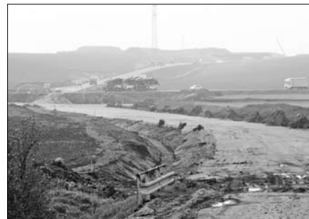
Nájezd na D1 - Cesta na Kroměříž je v souvislosti s budováním dálničního sjezdu uzavřena.
