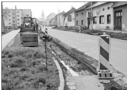
Osazování obrubníků a příprava na opravu vozovky v Olomoucké ulici.
