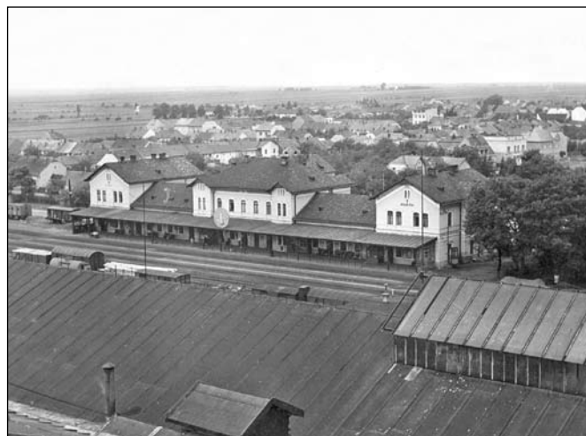
Pohled na kojetínské nádraží tentokrát od bývalého cukrovaru, rok neznámý
