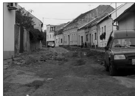
Růžová ulice byla po budování kanalizace v žalostném stavu. Právě probíhá její oprava do nové podoby, investorem je Město Kojetín
