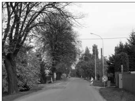
Prakticky poslední úsek kanalizace byl dokončen v uplynulých dnech na náměstí Svobody
