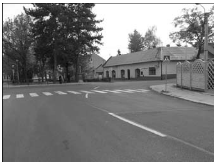
Opravená krajská silnice na křižovatce u ZŠ na nám. Míru
