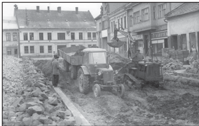
Oprava silnice na Masarykově náměstí v roce 1963
