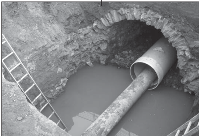
Důvodem kácení stromů je rekonstrukce této kanalizační šachty na ulici Sv. Čecha
