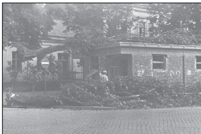
Po větrné smršti 13. srpna 1957 v Kojetíně u veřejných WC. Podle zápisu v kronice strašná smršť vyvrátila spoustu stromů ve městě a okolí a na hřbitově vyvrátila 13 pomníků.
