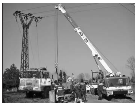
K instalaci čerpadla musela být vyhloubena jáma a povolán jeřáb
