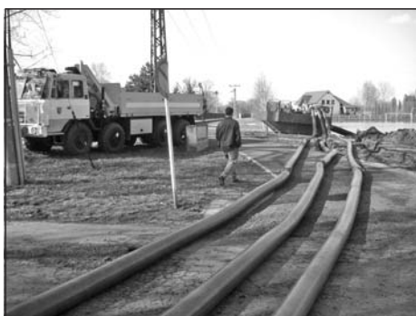
Speciální čerpadlo mělo neuvěřitelný výkon až 800 l vyčerpané vody za vteřinu
