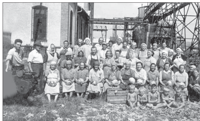
Dělníci kojetínského cukrovaru při opravě závodu po 2. světové válce
