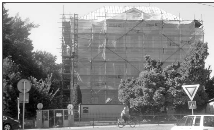
Rekonstrukce ZŠ Sv. Čecha
