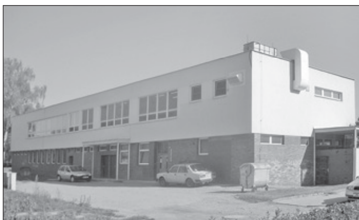
Rekonstrukce školní jídelny
