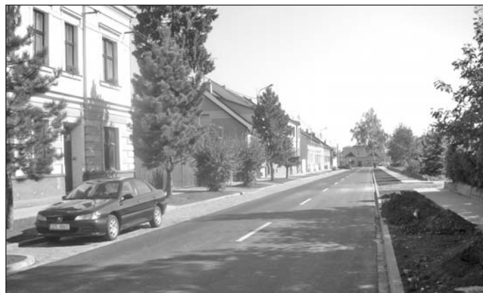
Oprava ulice Nádražní
