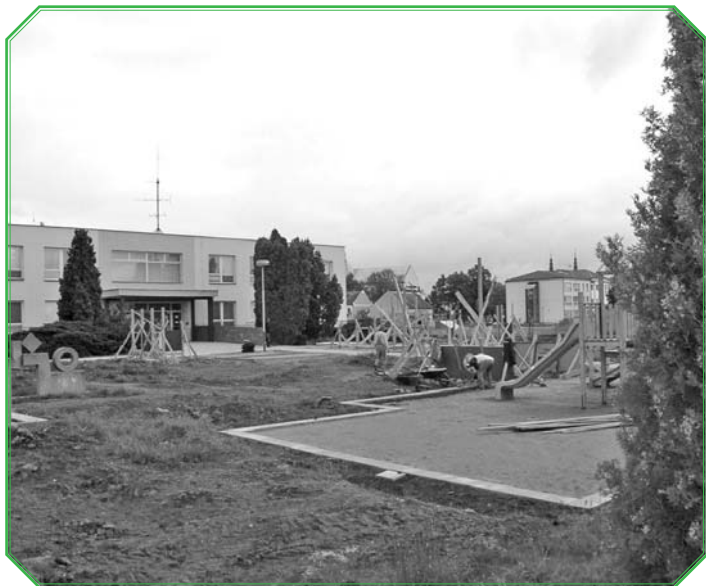
Z prací na modernizaci areálu školní zahrady v mateřské škole v Hanusíkově ulici
