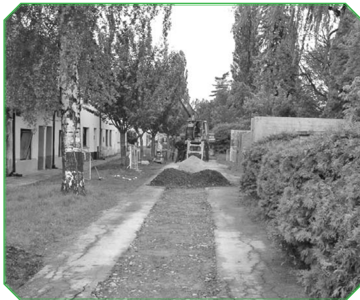
Práce na vybudování kanalizace na náměstí Svobody právě začaly
