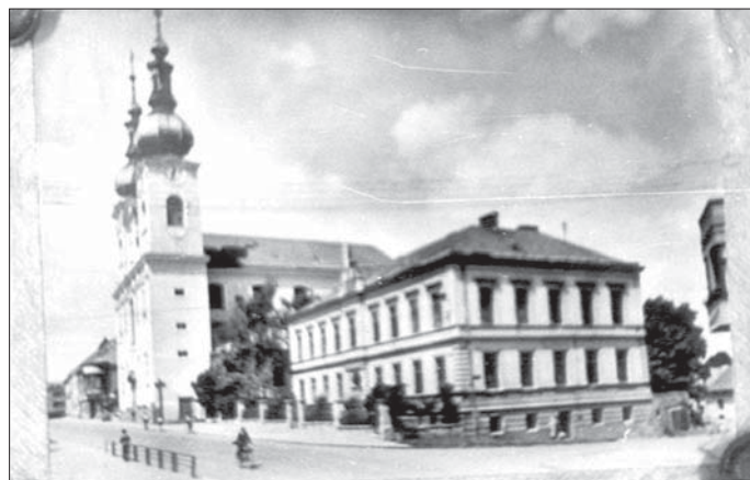
Pohled na Komenského náměstí s budovou kláštera a kostelem Nanebevzetí Panny Marie, zřejmě v 30. letech 20. století
