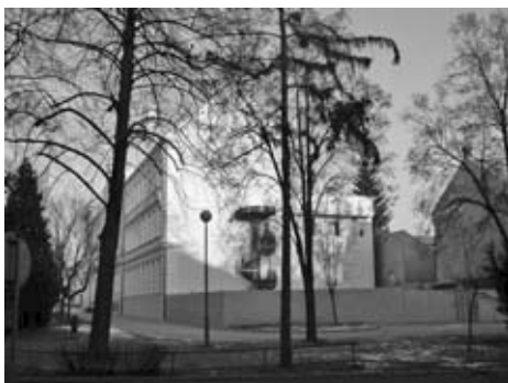
Oprava ZŠ nám. Míru
