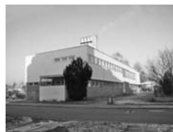
Oprava školní jídelny
