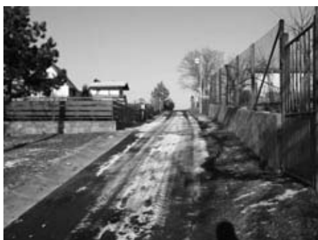
Oprava komunikace v Kovalovicích
