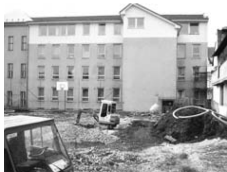
Oprava hřiště u ZŠ Sv. Čecha
