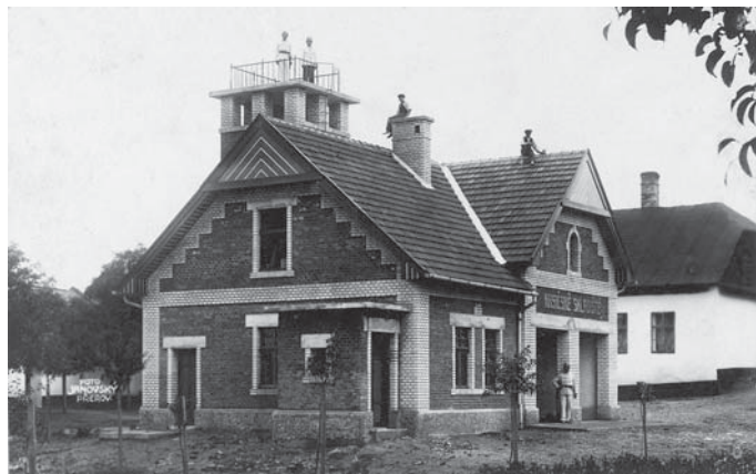
Troubky – původní budova hasičské zbrojnice v roce 1925
