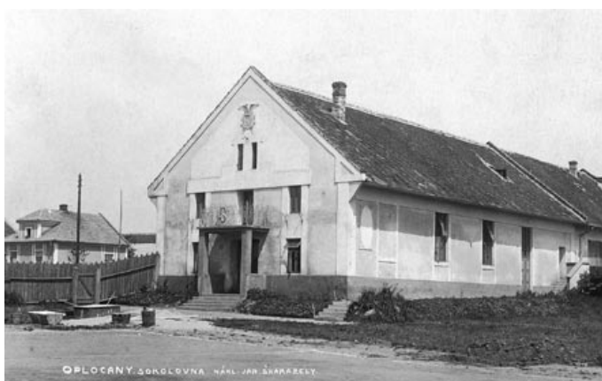
Oplocany – opravená budova sokolovny
