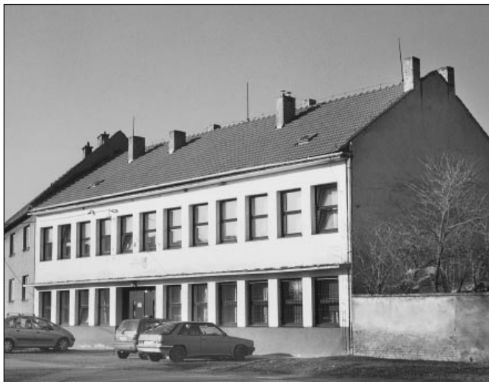
Oprava střechy na budově Základní umělecké školy v Hanusíkově ulici
