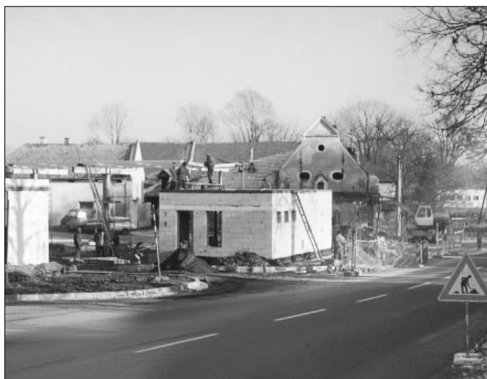
Likvidace bývalé benzinové pumpy a stavba nového zařízení na Tržním náměstí
