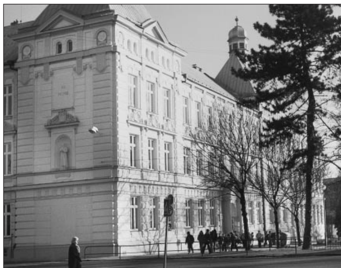
Oprava budovy ZŠ nám. Míru, která oslavila 100 let od svého založení. Její oprava a přístavba bude probíhat také v roce 2004.
