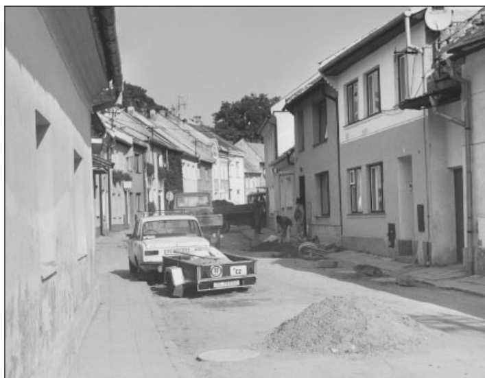
Vybudování kanalizace v Husově ulici
