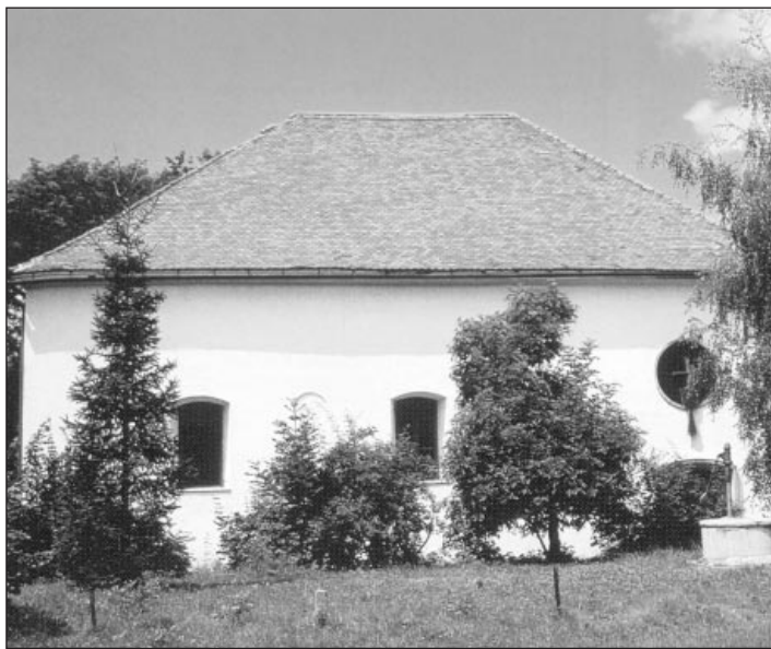
Budova synagogy v podobě před rekonstrukcí.
