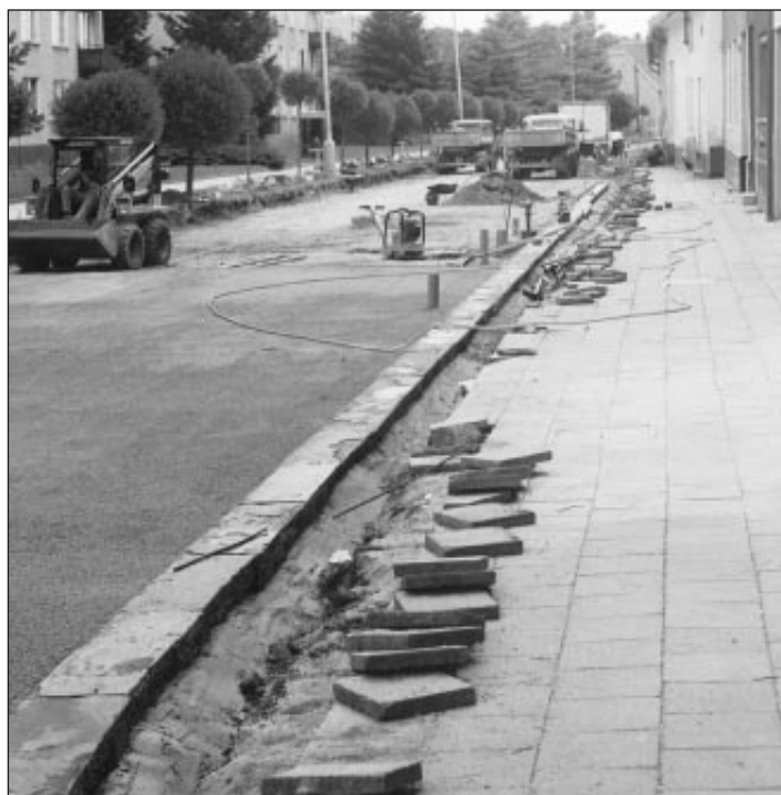
Oprava vozovky v Tyršově ulici byla dokončena před Kojetínskými hody
