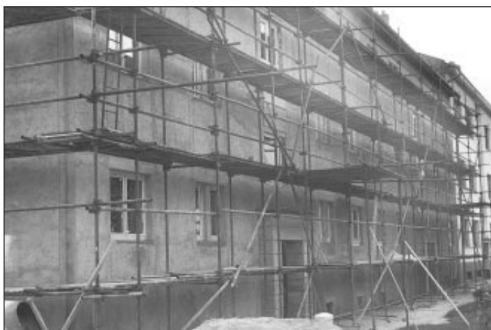
Oprava domu v ulici Kuzníkova
