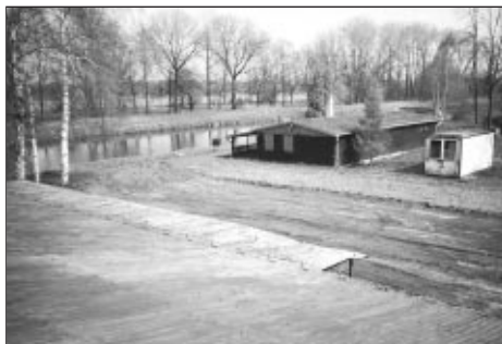
Budování hřiště - úprava terénu 16. 4. 2002
