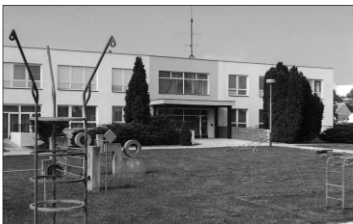
Oprava fasády mateřské školy včetně úprav vnitřního zařízení
