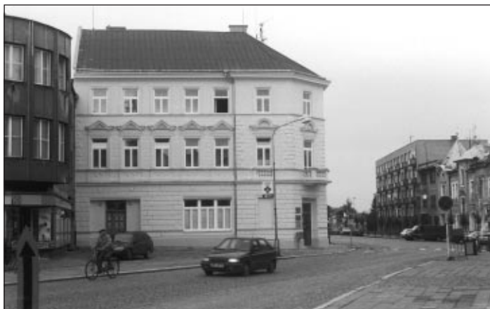
Oprava budovy pošty
