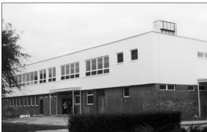
Oprava budovy školní jídelny a družiny
