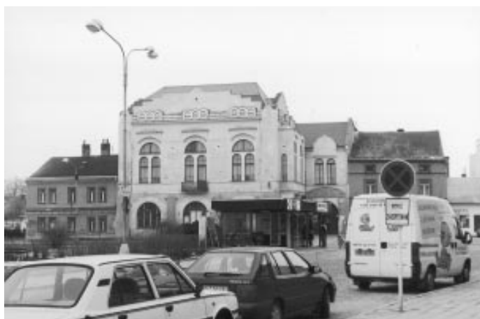
Rekonstrukce „Okresního domu“ na kulturní centrum města
