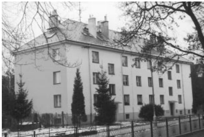
Půdní vestavby čtyř bytů včetně opravy fasády v ulici Sv. Čecha
