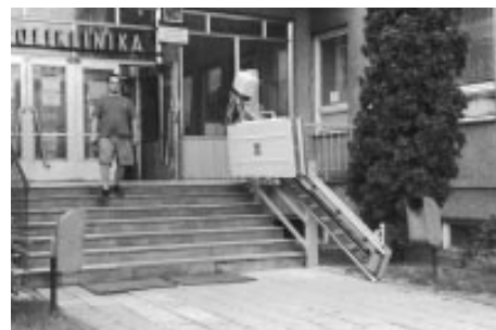
Instalace bezbariérového vstupu do polikliniky
