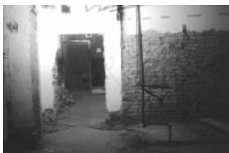
Rekonstrukce rehabilitace v suterénu polikliniky
