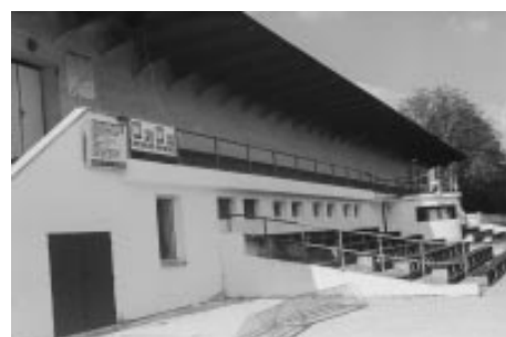
Oprava tribuny a sociálních zařízení fotbalového stadionu TJ Slavoj
