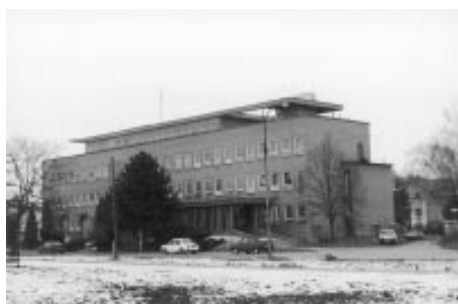
Oprava střechy a některých ordinací v budově polikliniky
