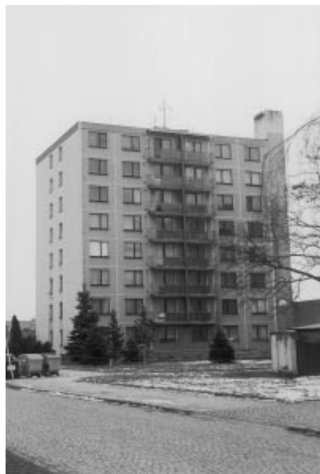
Rekonstrukce balkonů v Dudíkové ulici
