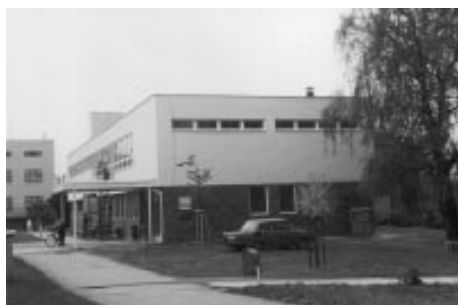
Oprava budovy školní jídelny a družiny v Hanusíkové ulici
