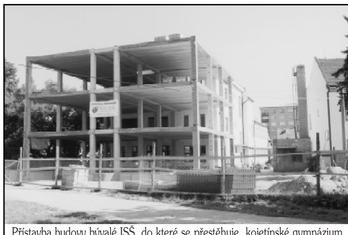
Přístavba budovy bývalé ISS, do které se přestěhuje kojetínské gymnázium
