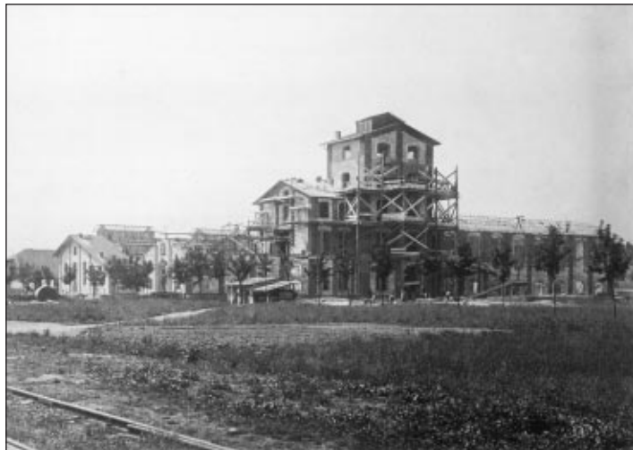
Výstavba lihovaru v roce 1914
