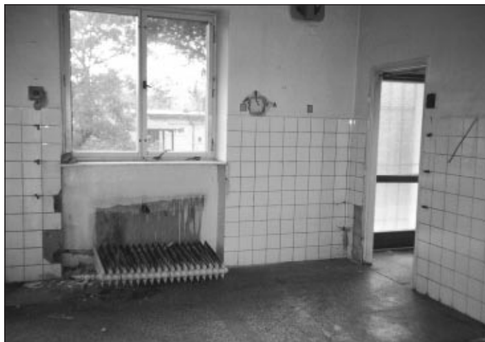
Ukázka stavu jedné místnosti bývalého Domova důchodců před tím, než zde firma Stavconsult Kroměříž začala provádět rekonstrukci na Dům s pečovatelskou službou.
