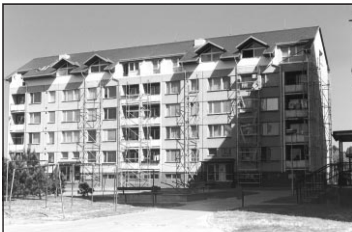
Železniční stavitelsví Brno, divize Olomouc dokončuje práce na půdních nástavbách v ulici J. Peštuky, kde vznikne šest nových městských bytů o velikosti 2 x 1+1, 2 x 2+1, 2 x 3+1.
