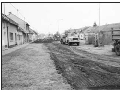
Další etapa budování kanalizace v ulici Padlých hrdinů
