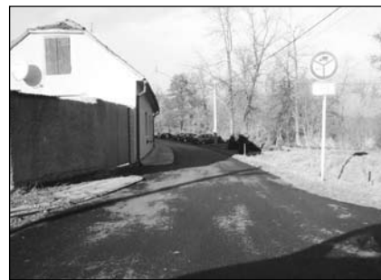
Oprava vozovky a chodníku ve Stružní ulici
