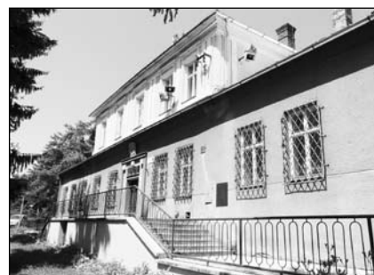
Oprava komínů na záměcku v Kovalovicích
