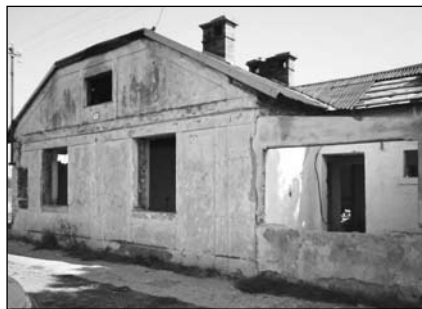
Demolice posledního z tzv. „Bílých domků“ na ulici Padlých Hrdinů
