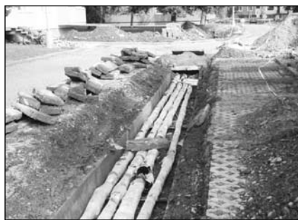
První etapa opravy teplovodního kanálu na sídlišti „Jih“
