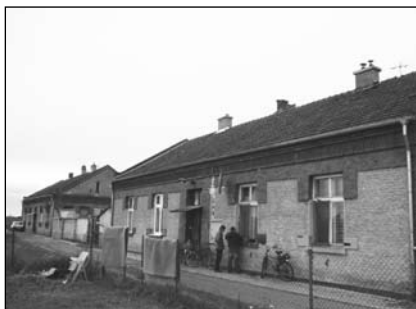
Oprava komínů na bytových domech č. p. 815 - 818
