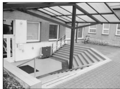
Instalace schodišťové plošiny u vchodu na DDM
