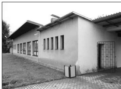
Rekonstrukce elektrické instalace v restauraci na koupališti
