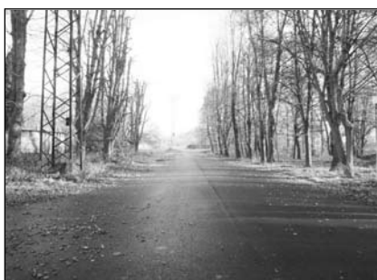
Oprava komunikace u fotbalového stadionu
