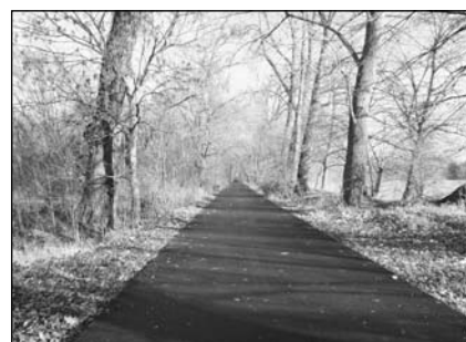
Oprava stezky v aleji Špalír Jiří Šírek
