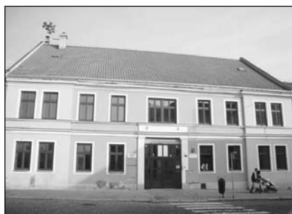
Výměna oken a vchodových dveří v budově MŠ na Masarykově náměstí
