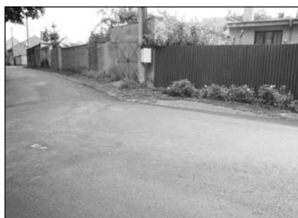
Oprava komunikace v parku na ulici Palackého
