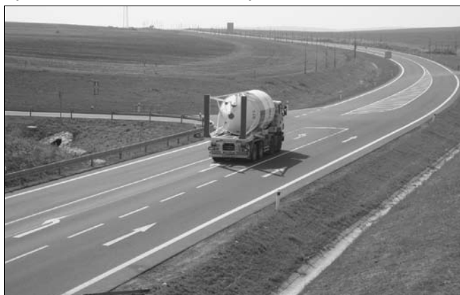
Stavba dálnice D1 u Kojetína spojila náš region s dálniční sítí v ČR
