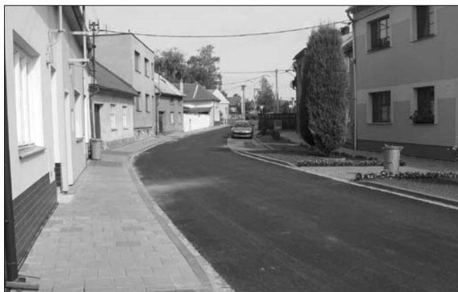
Rekonstrukce místních komunikací v ulicích Hanusíkova, Čsl. Legií a Dudíkova po budování kanalizace v této lokalitě.
