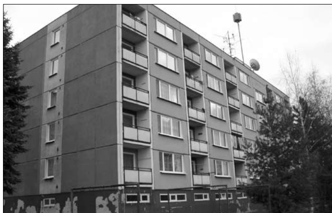
Výměna oken na DPS na ulici Jana Peštuky
