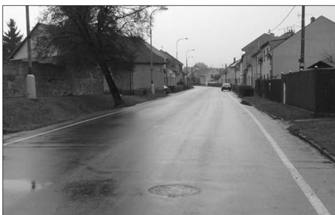
Opravy krajských silnic po budování kanalizace - Křenovská ul.
