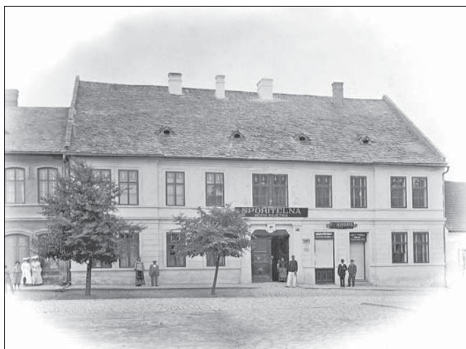
Obecní dům, nyní budova mateřské školy a MěDDM, kolem roku 1920
